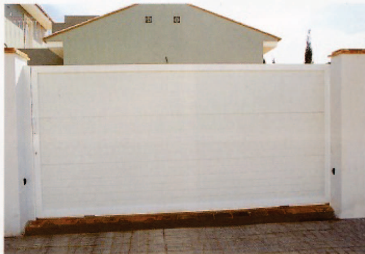
Cancela corredera, perfilera de aluminio con panel acanalado
